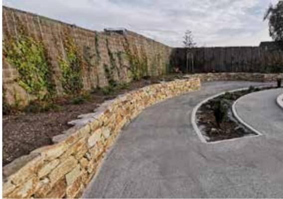
Anschließend wurde das Feinplanum für die Wege hergestellt. Als finaler Wegbelag wurde eine „wassergebundene Decke“ aufgebracht. Dieser Wegbelag ohne sämtliche Bindemittel ist im Gegensatz zu Asphalt etc. versickerungsfähig und wirkt sich dadurch positiv auf die Niederschlagsversickerung aus. Durch die gewählte hellere Farbe wird die Oberfläche im Sommer auch nicht so erhitzt. Im Vergleich zu dem herkömmlichen Splittbelag kann er auch mit Rollstühlen und Rollatoren befahren werden.
